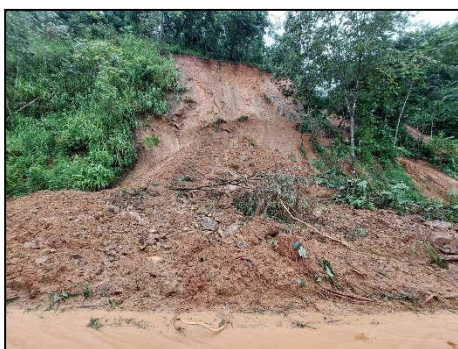
ภาพที่ 5.2.2-1 บริเวณ กม.495+400 พบดินไหลลงสู่ผิวจราจร
